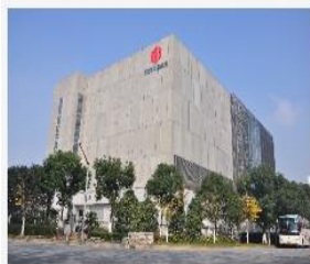
万国数据外高桥数据中心
